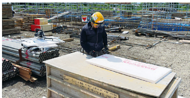
雪印メグミルク磯分内工場の建設現場にて
